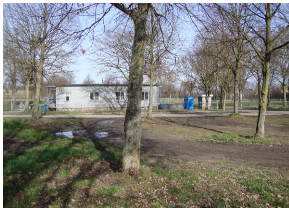
Kantine/kleedruimte VV Daalhof
